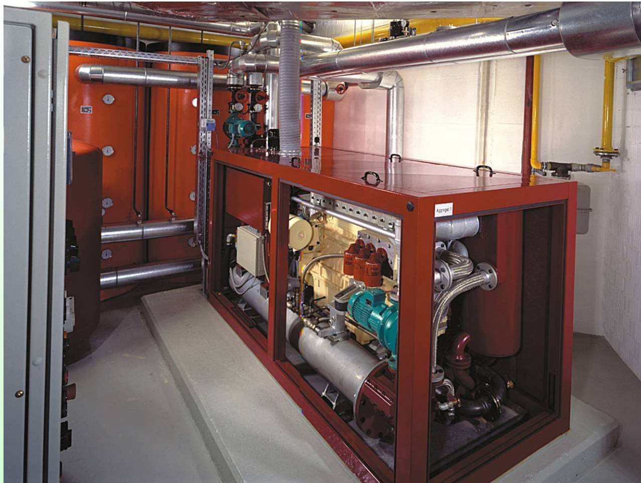
Blockheizkraftwerk
