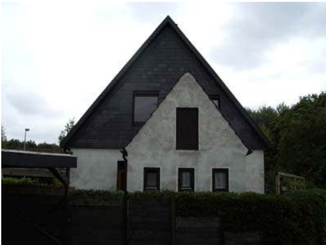
Abb. 2: Ostansicht mit Anbau
