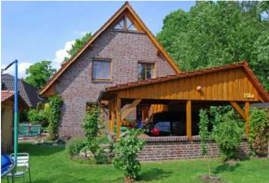
Doppelhaushälfte in Wardenburg Baujahr 1999 z.Zt. 5 Bewohner Wohnfläche ca. 125 qm
